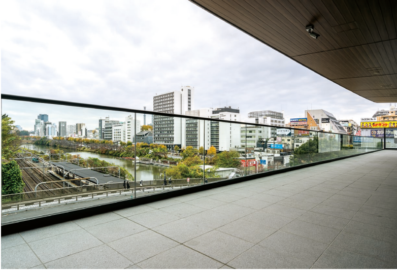
飯田橋駅西口駅舎のテラスに設置されたガラスフェンス 自立型で支柱のない構造のため眺望が開ける ＊
