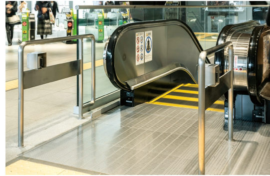
エスカレーターの乗降口に設置されたベルトリールパーティション 点検や作業のさいにベルトを引き出し乗降口を塞ぐ ＊
