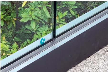
ガラスフェンスのガラス固定部分 充填剤を使わないのでガラス破損時の取り替えが容易という利点もある
