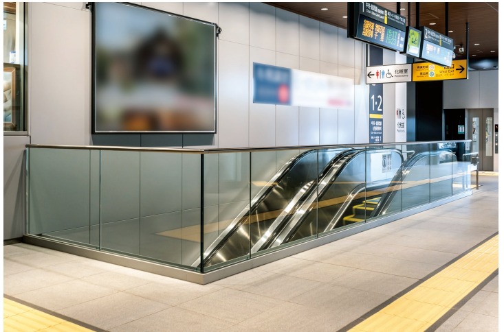
エスカレーターの乗降口に設置されたベルトリールパーティション 点検や作業のさいにベルトを引き出し乗降口を塞ぐ ＊
